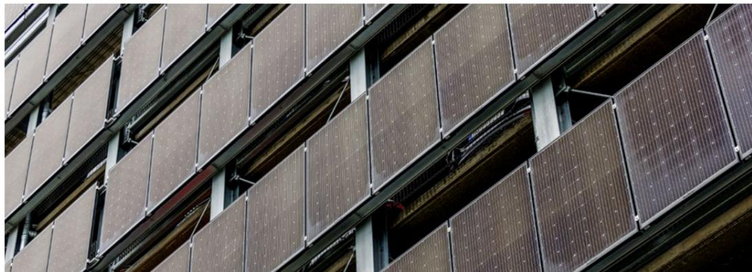
Erhöhung der regenerativen Eigenerzeugung am Standort als wichtige Maßnahme – hier abgebildet vertikal installierte Photovoltaik-Paneele an der Fassade eines Parkhauses.
