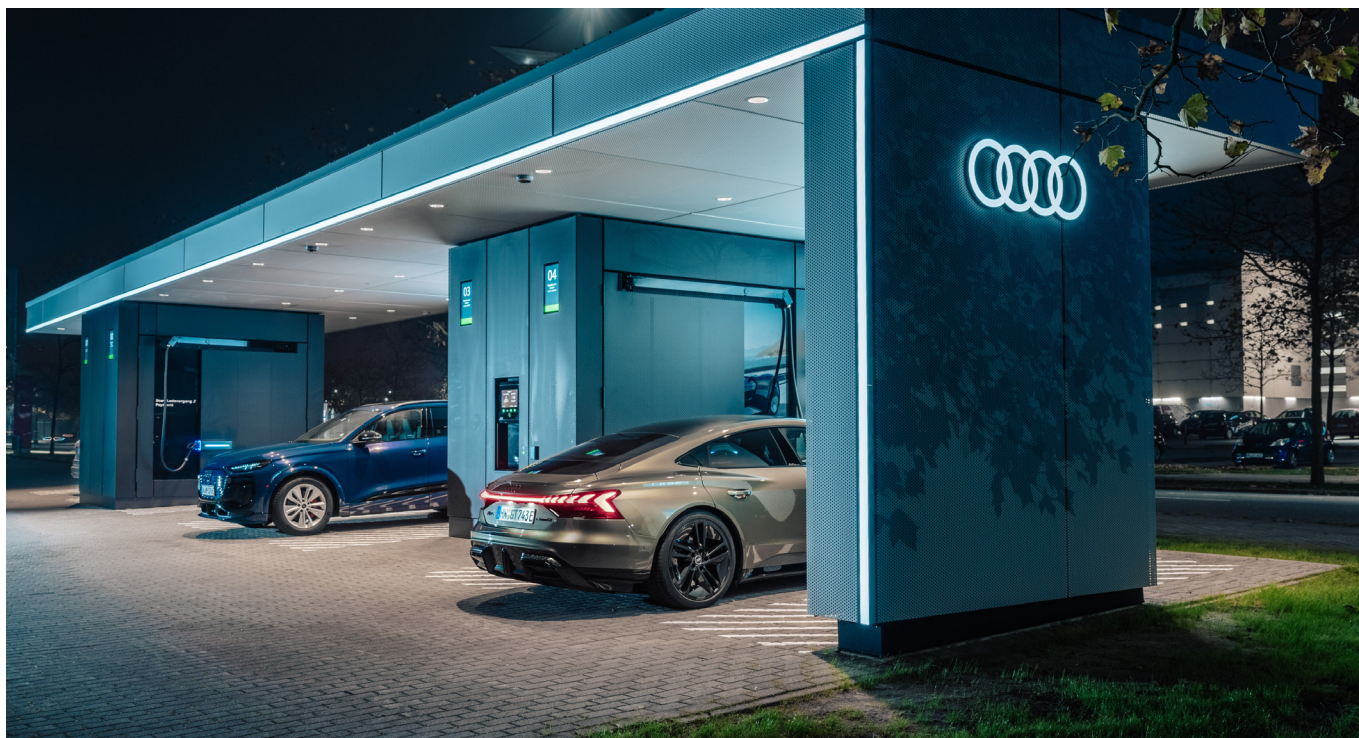
Audi charging hub in Bremen: Audi setzt einen weiteren Meilenstein beim Ausbau seiner urbanen Ladeinfrastruktur.
